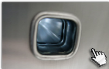
4-fach gebördelte Sprossen-Holmverbindungen
