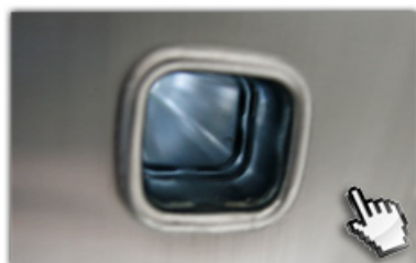
4-fach gebördelte Sprossen-Holmverbindungen
