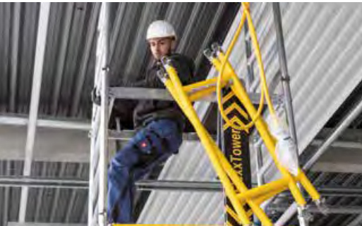
Weitere Aufsteckrahmen einsetzen Obere Plattform einhängen
