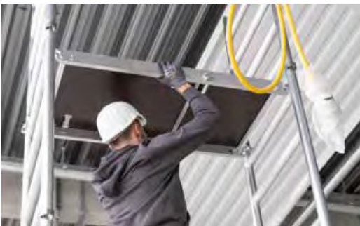
Weitere Aufsteckrahmen einsetzen Obere Plattform einhängen
