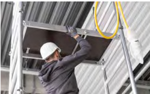
Weitere Aufsteckrahmen einsetzen Obere Plattform einhängen
